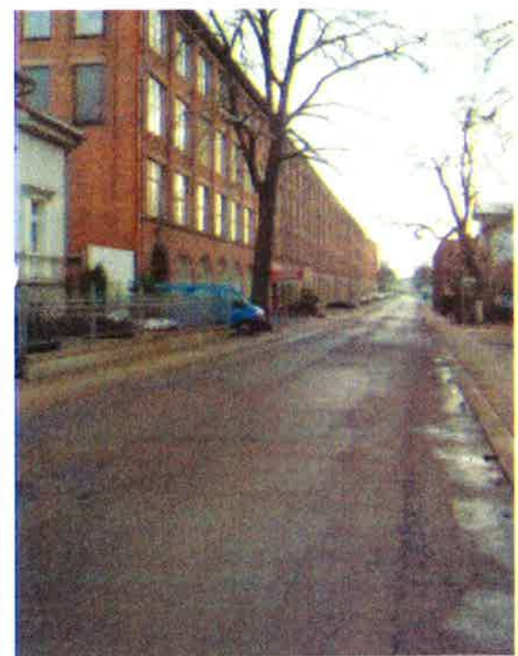
geplanter Bauabschnitt Uferstraße - Richtung Süden
