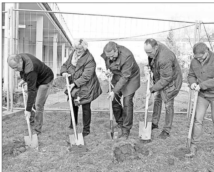
Sie absolvierten den ersten Spatenstich (v. l. n. r.): Wolfgang Walter (bausausführende Firma ULT), Monika Schulz-Höpfner (Kreistagsvorsitzende), Gerd Glasche (Vorstand Haus der Familie), Stefan Palm (Landschaftsarchitekturbüro Engelmann) und Stefan Müller (zuständiger Fachbereichsleiter in der Gubener Stadtverwaltung). Foto: swi
