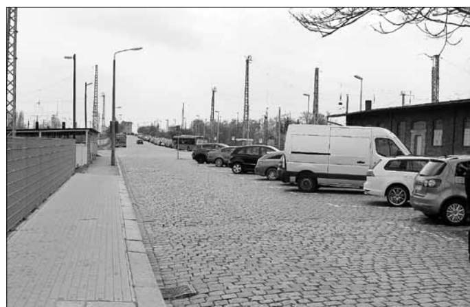
Blick in die Bahnhofszufahrt, die bis Ende 2018 grundhaft erneuert wird.
