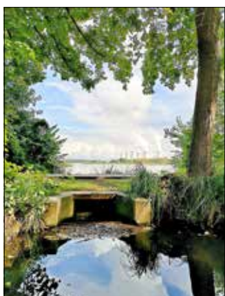
Der Hammergraben dient als Zuleiter für die Peitzer Teiche.
