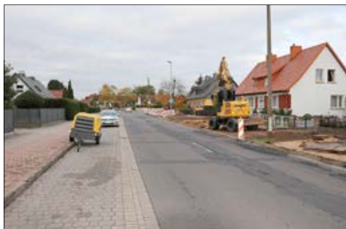
Baumaßnahmen in der Otto-Thiele-Straße © Stadt Guben
