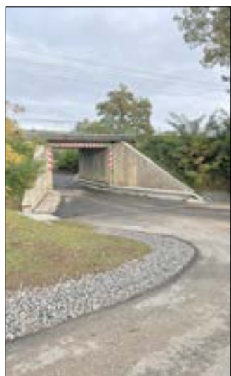
Bauunterführung Kuckucksau © Stadt Guben
