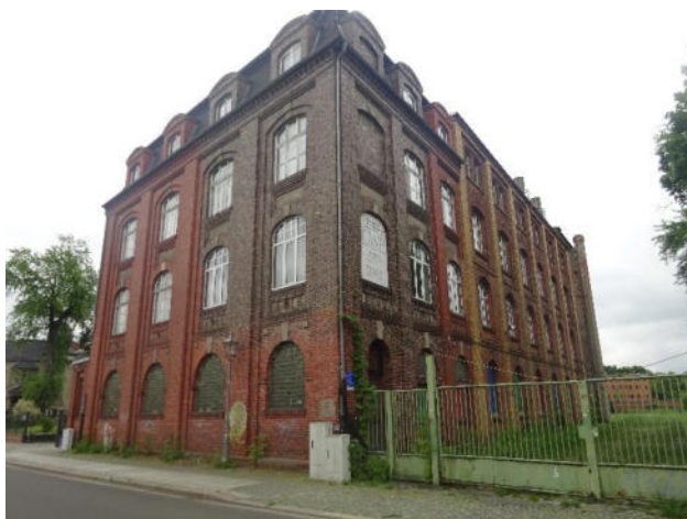
Abb. 34: Alte Poststraße 59, Ansicht vom Straßenraum (Quelle: B.B.S.M.)
