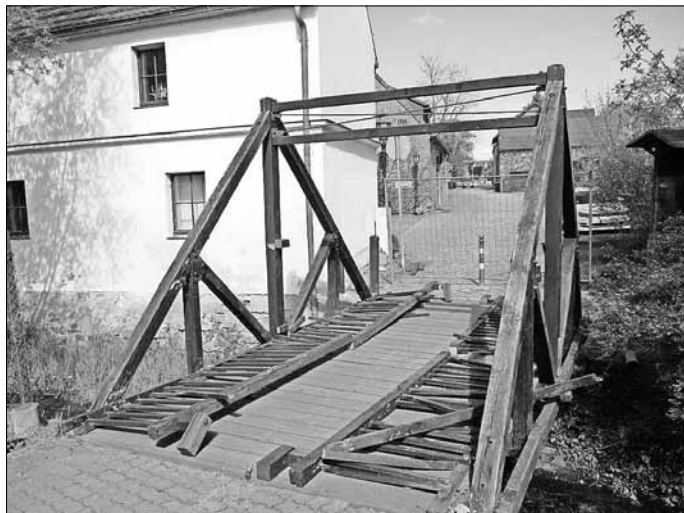
Blick auf die alte Brückenkonstruktion. Foto: ml
