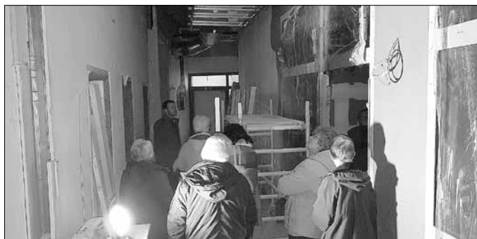
Aktuelle Ansicht der Baustelle. Foto: Stift
