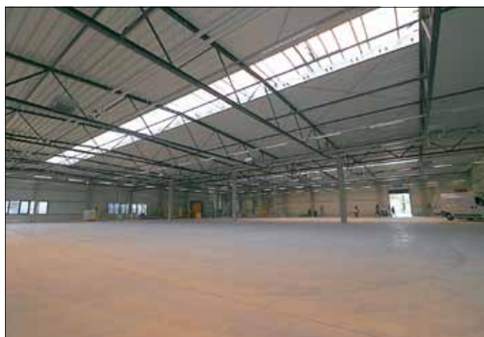
Blick in eine Halle des neuen ATT -Logistikzentrums. Fotos: bs
