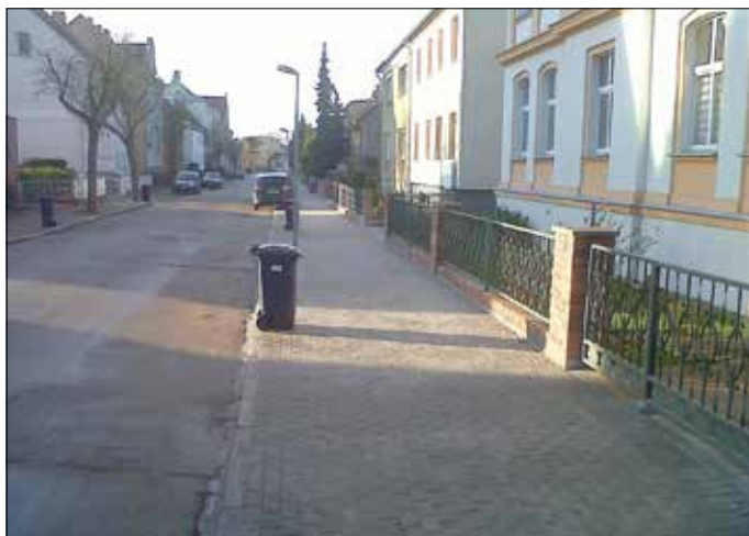
Blick auf den erneuerten Gehweg in der Dr.-Ayrer-Straße
