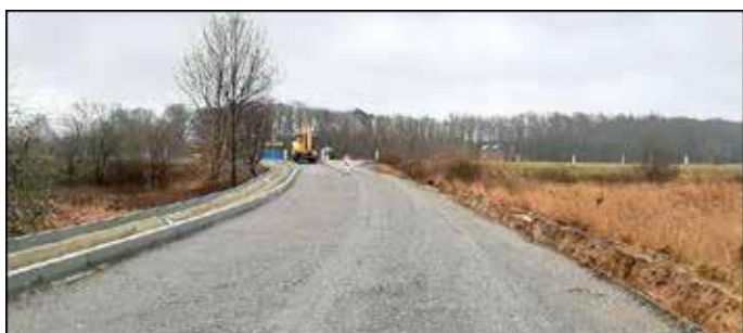
Im Rahmen der Schulwegsicherung wurde die Einfahrt nach Schlagsdorf , zwischen der Kreisstraße und dem Bahnübergang erneuert. Zusätzlich wird ein Gehweg geschaffen, welcher seitlich mit einem Geländer versehen wird. Das Bild entstand Ende November, mittlerweile ist die Baustelle so gut wie abgeschlossen.
