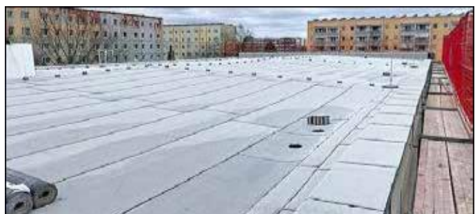
Dachsanierung der Europaschule-Turnhalle. Erneuerung der Abdichtung und der Dämmung entsprechend der Energieeinsparverordnung.
