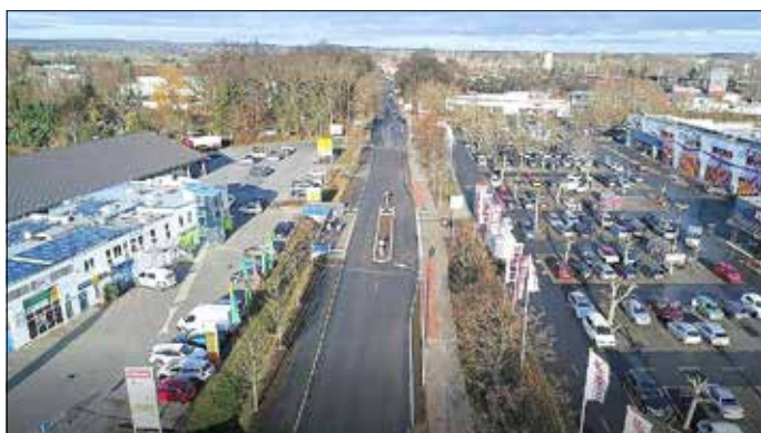
Die Baumaßnahme fand im Rahmen des Projektes „GUB-E-BUS – gemeinsame grenzüberschreitende Mobilität in der Eurostadt Guben-Gubin“ statt. Foto: Stadt Guben
