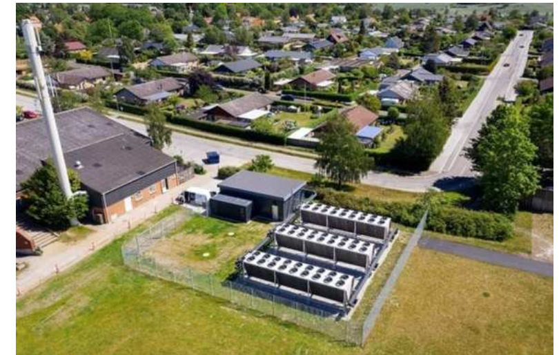
Beispiel von Rückkühlern zu einer Luftwärmepumpe 1,2 MW, Slagslunde, Dänemark
