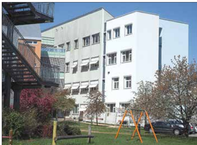
Haus 5A - nun ohne Baugerüst – zeigt Gesicht, Foto: Naëmi-Wilke-Stift
