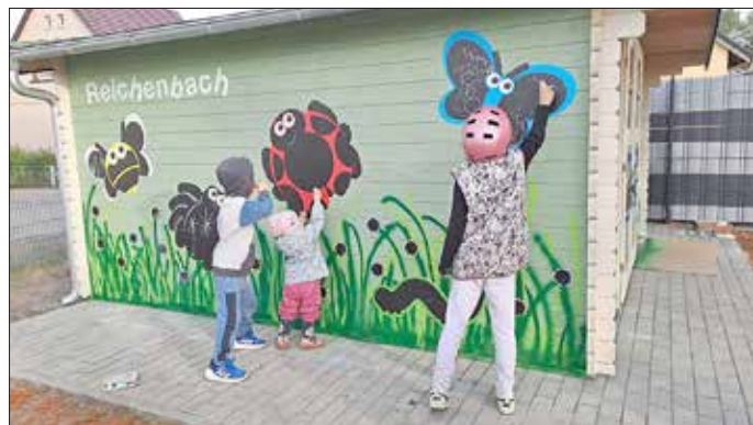
Fertiggestelltes Spiele- und Gerätehaus.
