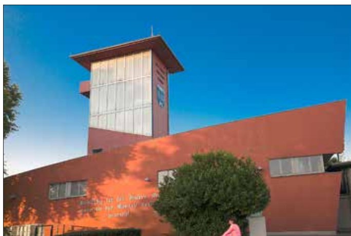
Gubener Brandschutz-, Rettungs- und Katastrophenschutzzentrum.
