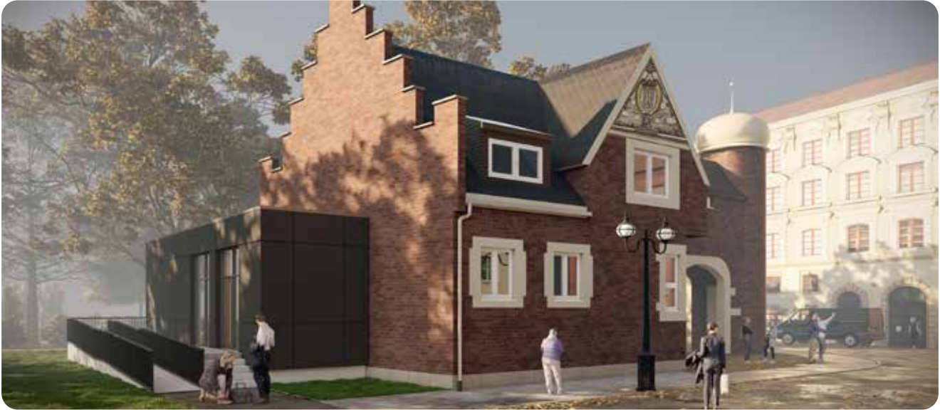
Das Torhaus bleibt erhalten und soll – wie schon vor 100 Jahren – als Eingang zur dahinterliegenden Bebauung dienen. © igb AG
