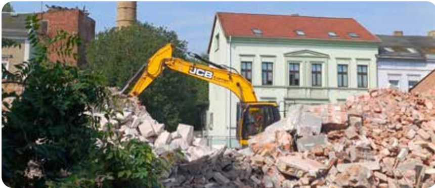
Die bei einem Brand 2023 schwer beschädigten Baracken an der Gasstraße 8 werden derzeit abgerissen.
