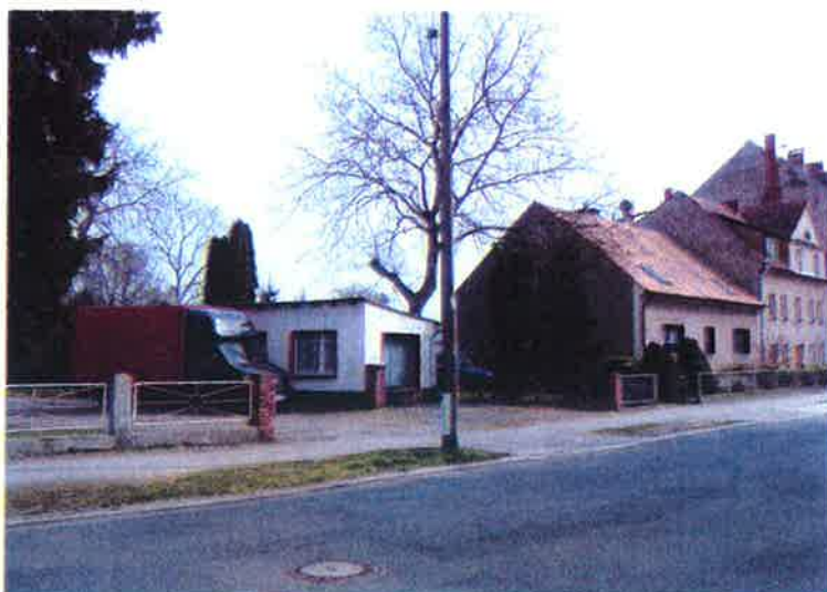
Baubeginn Kaltenborner Straße 12
